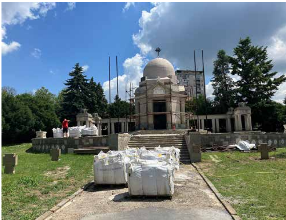
Rekonstrukce kaple na hřbitově Novo Groblje (květen 2025)
