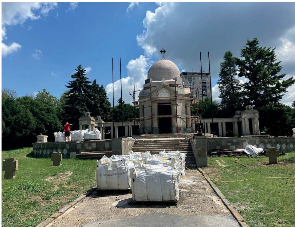
Rekonstrukce kaple na hřbitově Novo Groblje (květen 2025)
